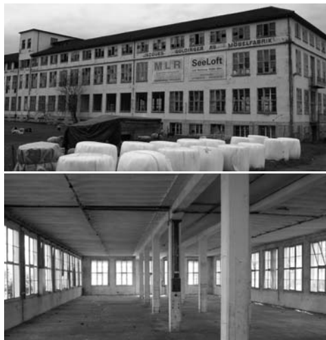
So sah die herunter gekommene Fabrikliegenschaft vor dem Umbau aus.
